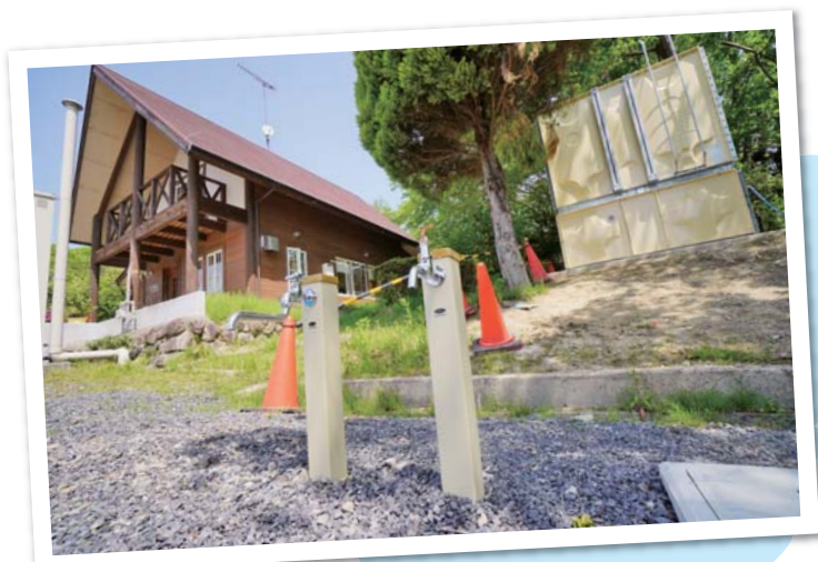
地下水は一旦貯水槽に溜められ、手前にある2つの蛇口から配水されます。
