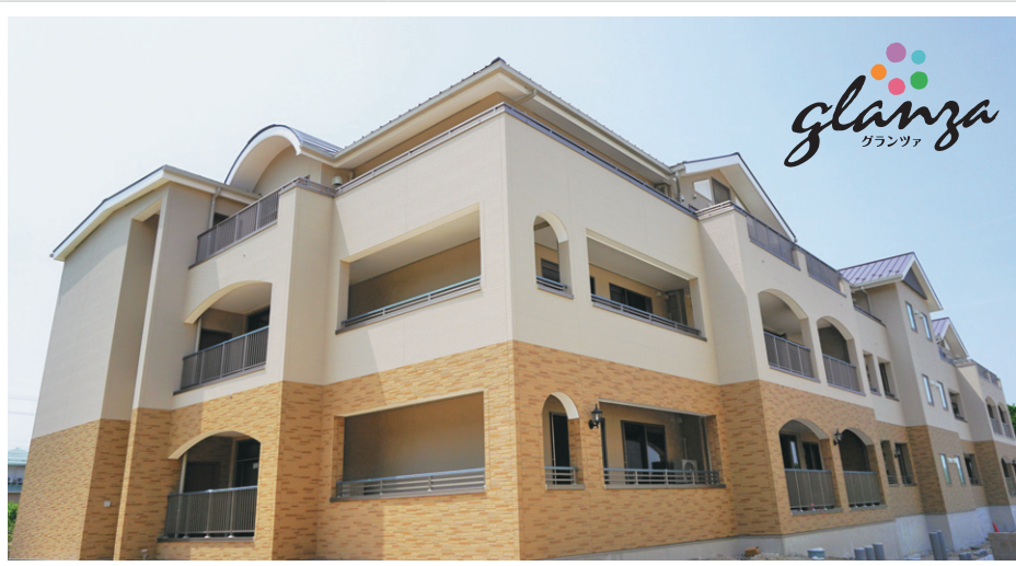
断熱効果に優れた、三重県初の3階建て耐震耐火大型木造建築。定員は60名。(5月11日撮影)
