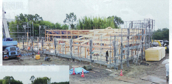
7月中旬の様子。いよいよ建屋工事の始まりです。
