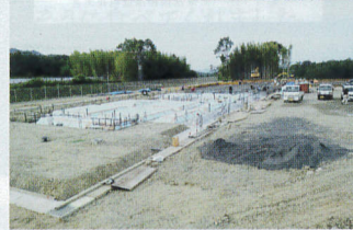
7月初旬の様子。基礎工事がほぼ終了です。
